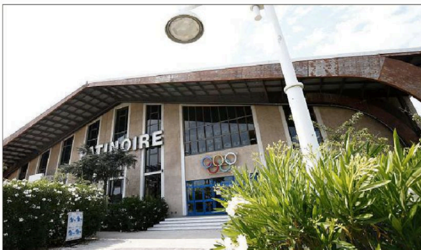
Un arrêté de fermeture de mise en péril était en préparation hier soir.
